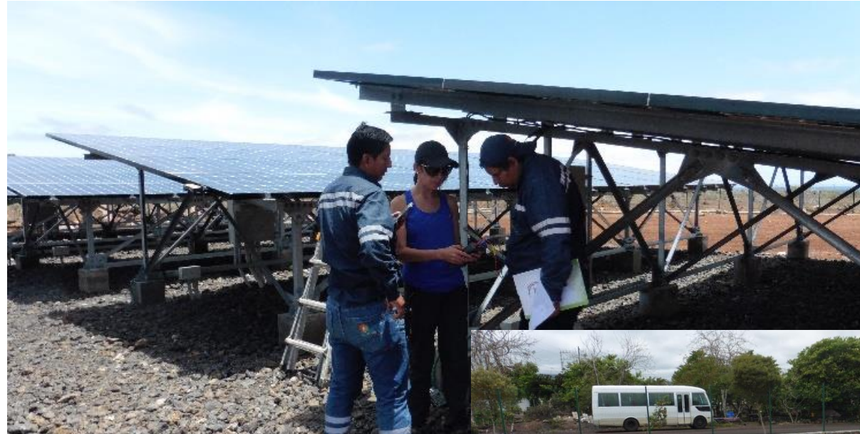
Planta FV (67 kWp) - Baltra
